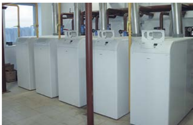
Кинотеатр, г. Йошка-Ола Общая мощность - 1,6 МВт
