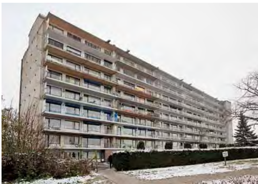
Жилой дом в Бельгии, теплоснабжение которого осуществляется за счет избыточного тепла завода по сжиганию мусора.
