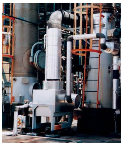
Компаблок – ребойлер десорбционной колонны этилацетата на заводе в Родиа, Бразилия
