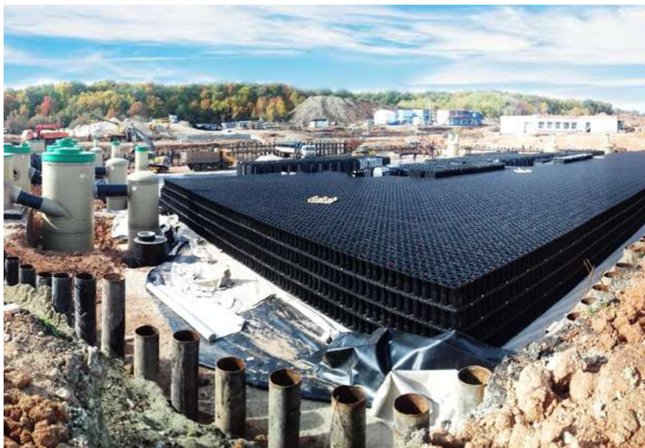
Совместное использование сепаратора CGS с резервуарами ACO StormBrixx
