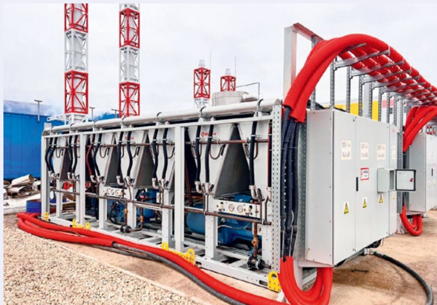
Чиллеры Thermex Energy TMR со встроенным фрикулингом на объекте
