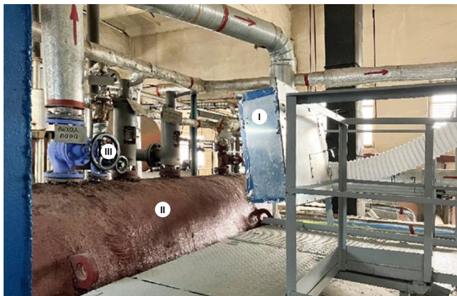
❖ Фото 1. Фотография с места установки лучисто-конвективной панели в котельной (рабочая зона обслуживания у верхнего барабана котельного агрегата; вид А: I — задвижка, II — верхний барабан котельного агрегата, III — задвижка)
