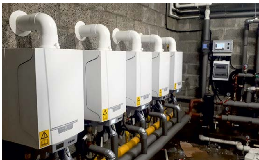
❖ Каскад из настенных газовых конденсационных котлов PMC-S 34 серии Naneo S
