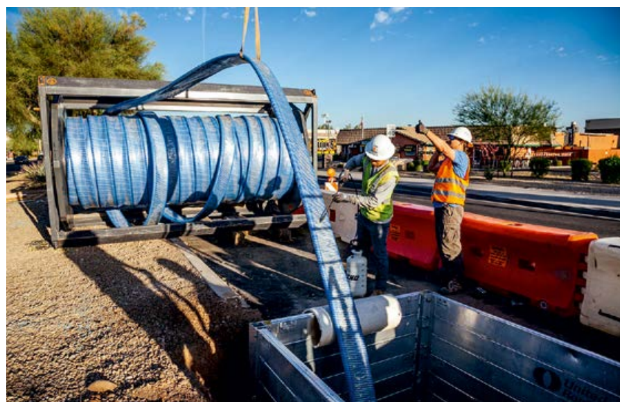
Бестраншейная замена труб с использованием рукавов-шлангов Primus Line в городе Пеория (штат Аризона, США) в марте 2018 года. Работы велись компанией Achen-Gardner Construction
