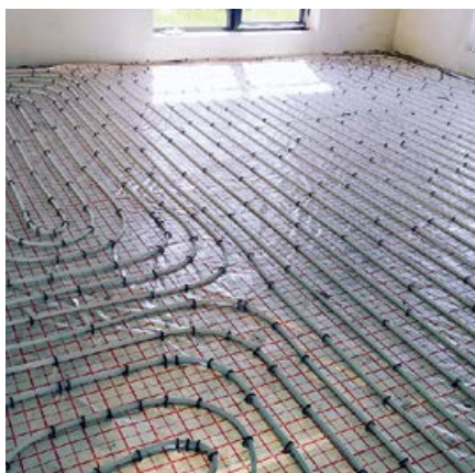
❖ Монтаж тёплого пола в помещении здания Турунтаевского садика
