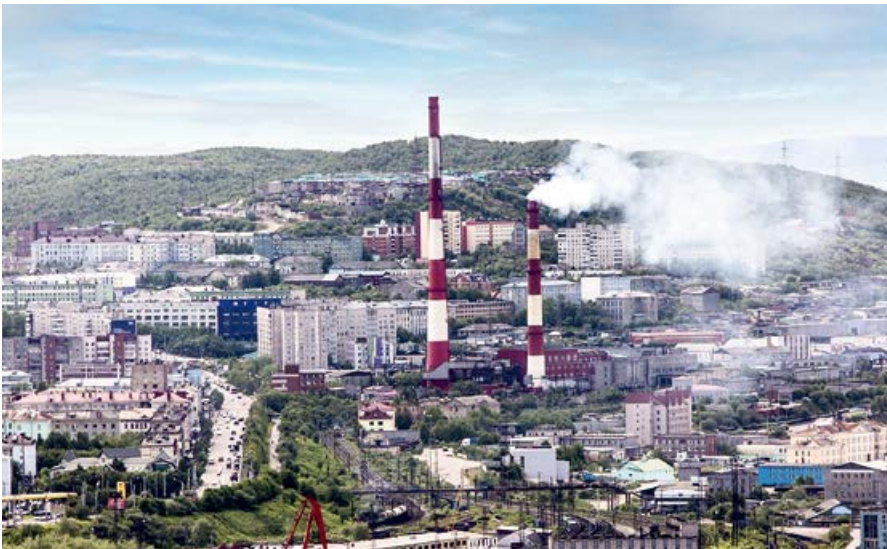
Мурманская ТЭЦ (электрическая мощность — 12 МВт, тепловая мощность — 1129,5 Гкал/ч) была построена по плану ГОЭЛРО в 1934 году. Ныне это дочернее предприятие ПАО «ТГК-1»
