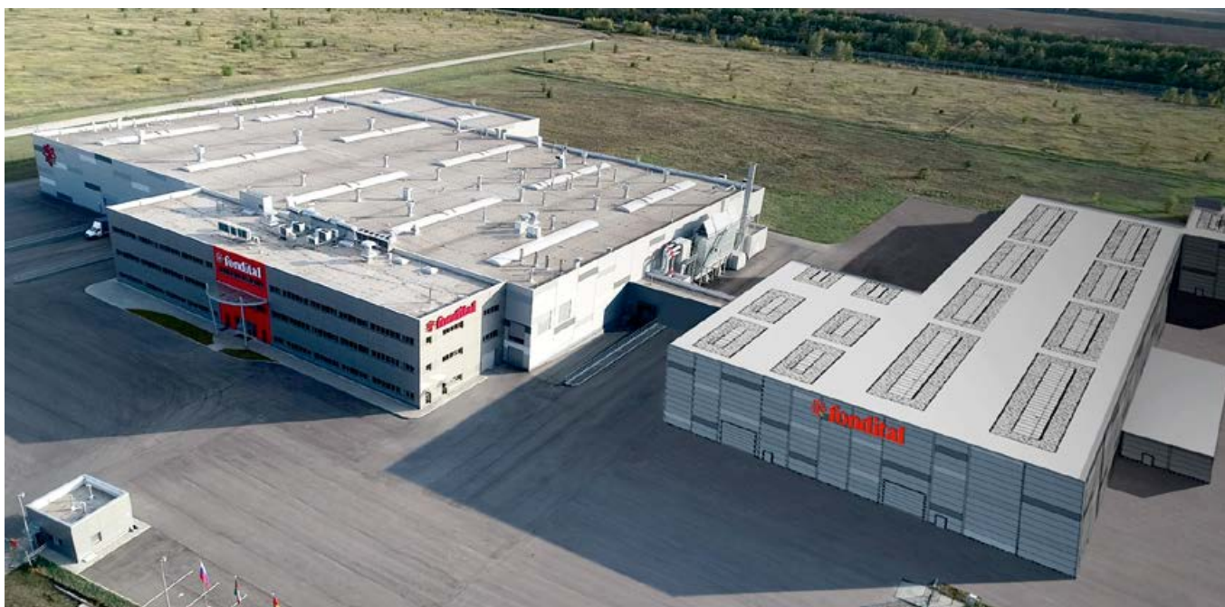
Завод итальянского производителя Fondital в городе Липецке
