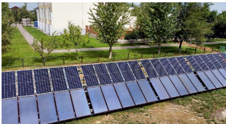
❖ Фото 5. Комбинированная солнечная нагревательная установка с использованием модулей PVT (PhotoVoltaic Thermal) для нагрева бассейна и горячей воды
