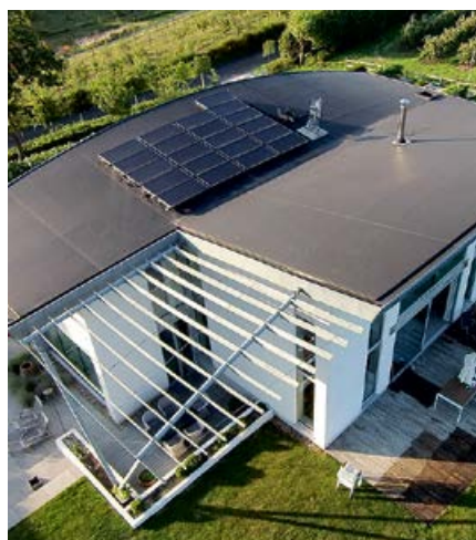
❖ Гибридный PVT-модуль на крыше дома
