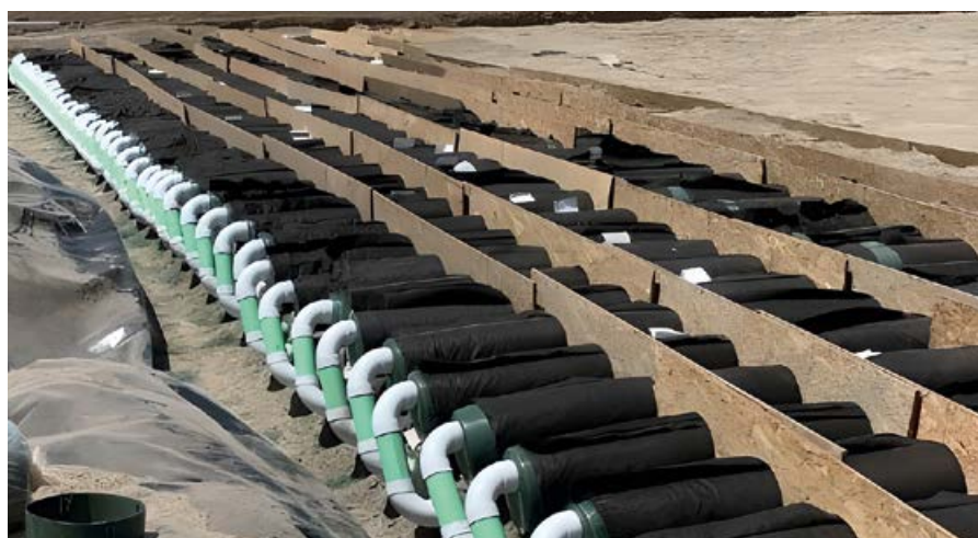
●● Рис. 4. Высокопроизводительный песчаный фильтр
