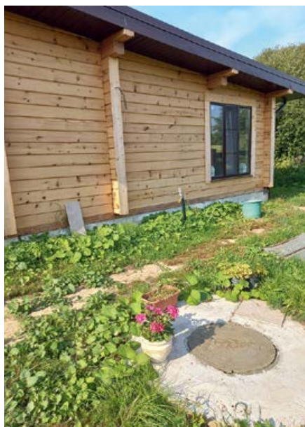
❖ Коллектор теплового насоса у дома-бани
