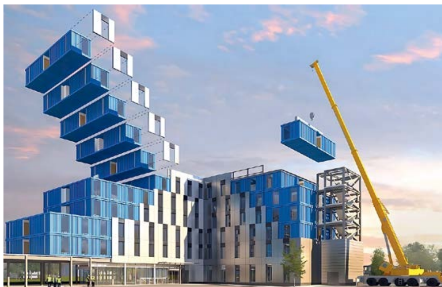
❖❖ Рис. 1. Схема сборки здания модульным методом
