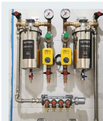
Примеры монтажа системы контроля протечек «Нептун» в системы горячего, холодного водоснабжения и отопления — краны с сервоприводами установлены на ключевых трубопроводах, перекрытие которых сразу ликвидирует случившуюся аварию
