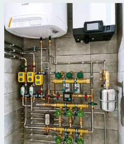
Примеры монтажа системы контроля протечек «Нептун» в системы горячего, холодного водоснабжения и отопления — краны с сервоприводами установлены на ключевых трубопроводах, перекрытие которых сразу ликвидирует случившуюся аварию
