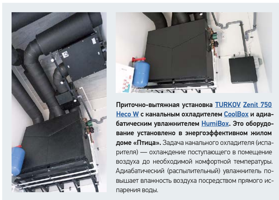
❖ Рис. 8. Приточно-вытяжная установка Zenit Cool Heco W от компании TURKOV
