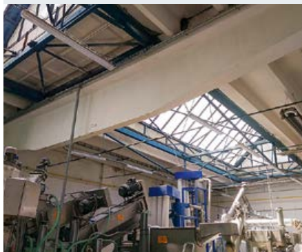
⊞ Газовое инфракрасное отопление на предприятии Renviro
