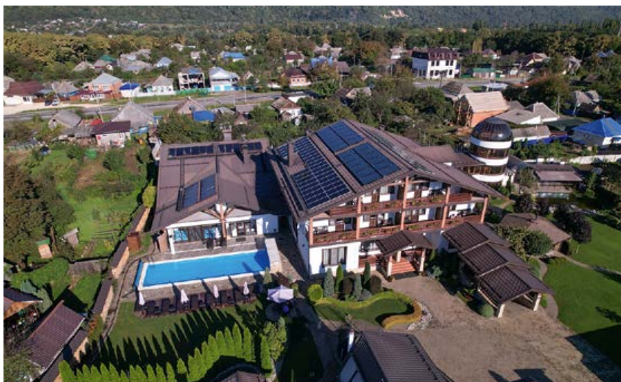
❖ Фото 3. ГУ с СК «НПО Машиностроение» и Vist Energy отеля «Усадьба Парфенова» в Адыгее
