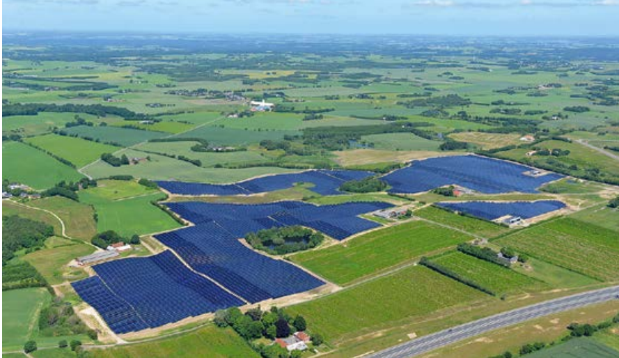
Мегаваттная ГУ в городе Силькеборге — крупнейшая в мире система солнечного отопления
