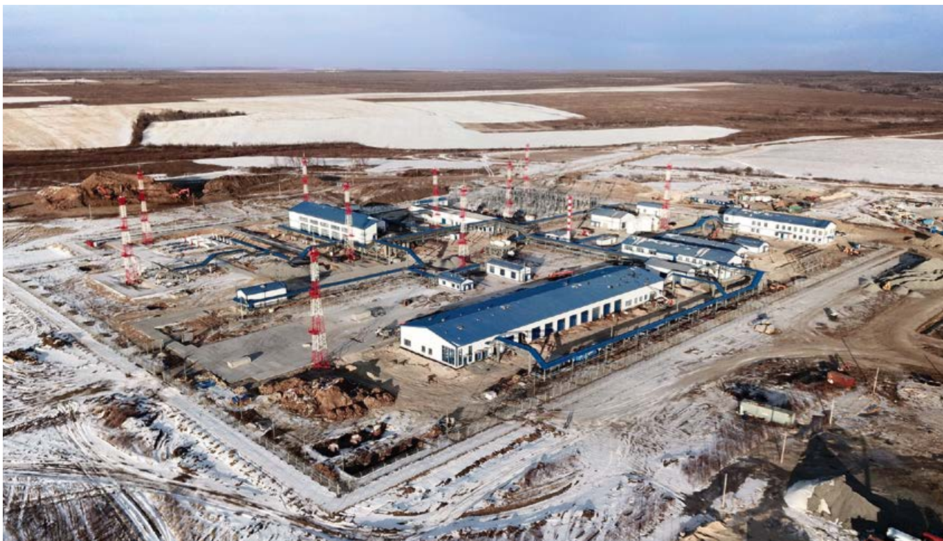
●● Первая в стране нефтеперекачивающая станция, построенная по 3D-модели
