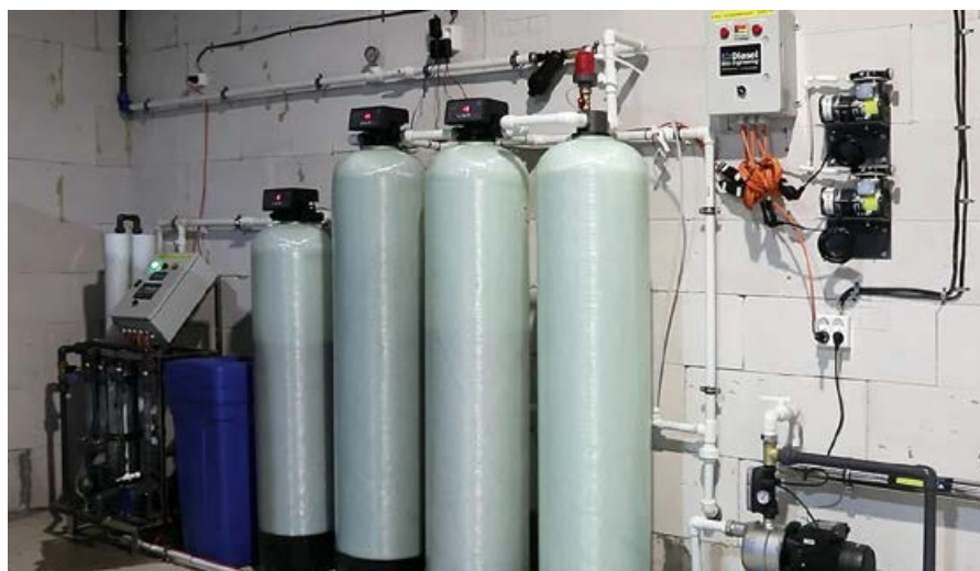
⌘ Рис. 4. Фильтры для доочистки воды компании Diaseel Engineering
