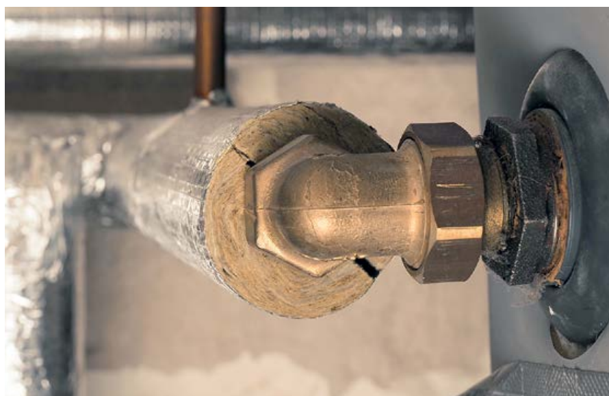
❖ Теплоизоляция трубопровода фольгированной минеральной ватой
