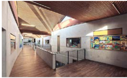
Школа Монтеessori в городе Ауферкингене (Бавария, Германия) сертифицирована по стандарту Passive House
