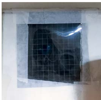
❖ Фото 4. Загерметизированное вентотверстие в ванной комнате жилой квартиры в Томске
