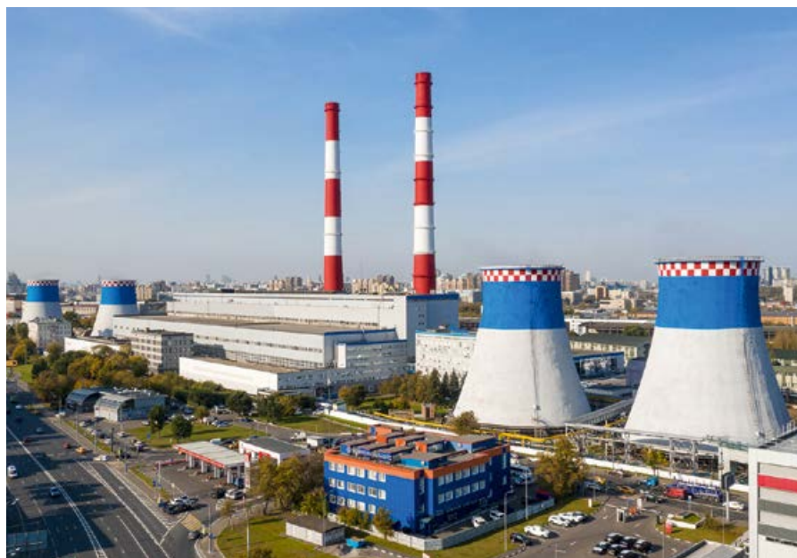
Фот. ПАО «Мосэнерго», mosenergogazprom.ru
