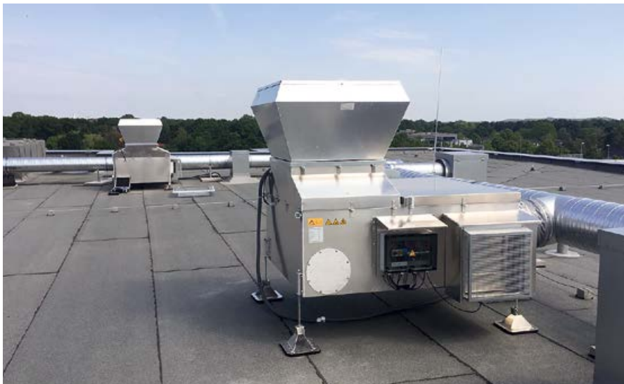
❖ Система вентиляции AWN с рекуперацией тепла для коллективного применения
