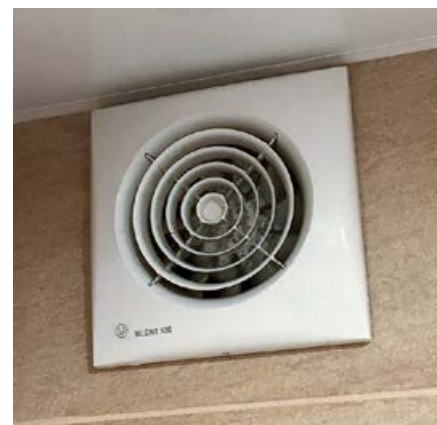
❖ Фото 2. Настенный вентилятор, установленный в ванной комнате квартиры на девятом этаже десятиэтажного дома в Томске
