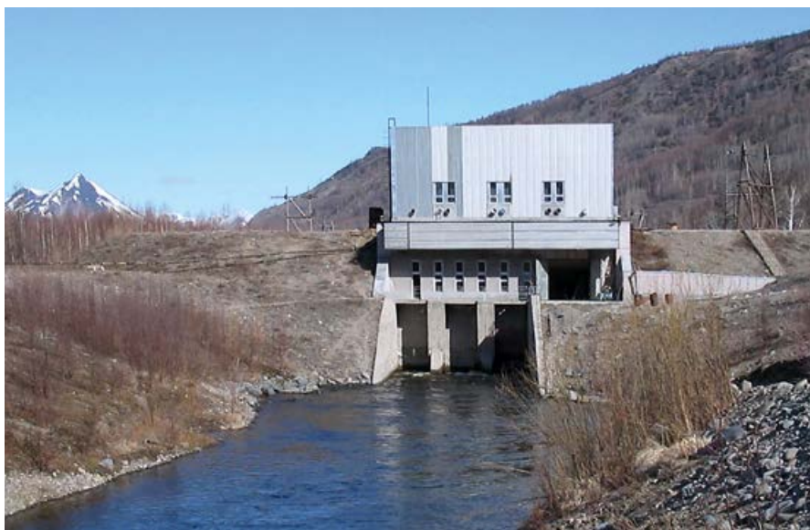
•• Первая на Камчатке гидроэлектростанция — Быстринская малая ГЭС деривационного типа (установленная мощность 1,71 МВт, годовая выработка 8,32 млн кВт·ч) на реке Быстрой
