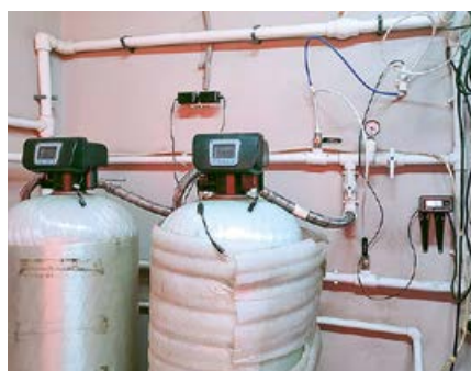
❖ Автомойка, на которой применена патентованная система контроля качества умягчённой воды
