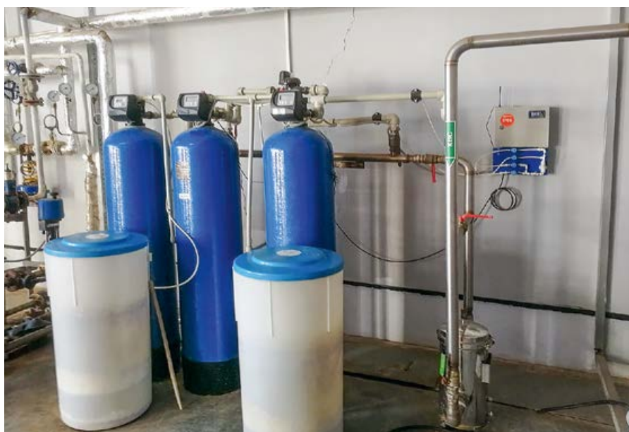
⌘ Фото 1. Двухступенчатая установка Na-катионирования воды с кондуктометрическим контролем умягчённой воды
