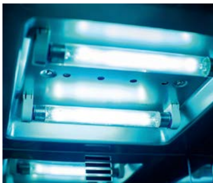
•• Секция с УФ-лампами в системе вентиляции
