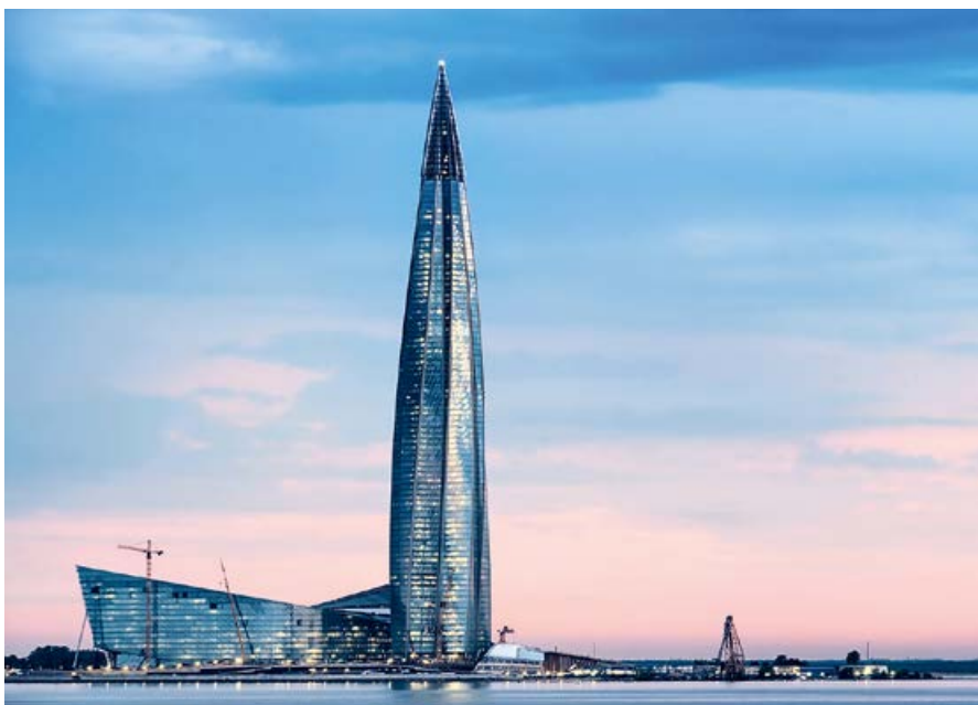
⚡ Общественно-деловой комплекс «Лахта-Центр» (г. Санкт-Петербург)
