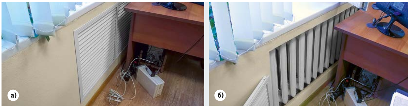
❖ Фото 2. Установка чугунного радиатора в «шкафном» укрытии (а — радиатор закрыт декоративной решёткой, б — решётка снята)
