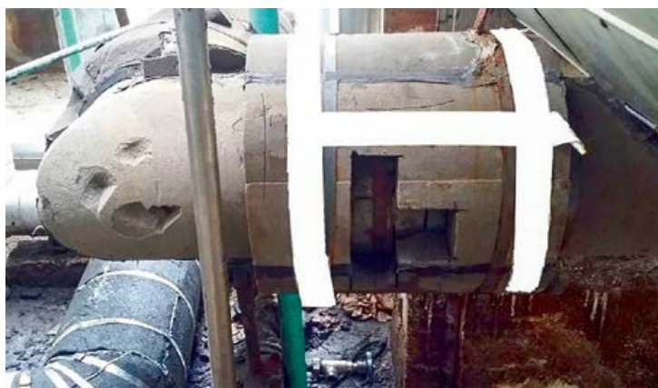
❖ Фото 2. Трёхслойное теплоизоляционное покрытие из пеностекла в процессе отбора образцов для испытаний
