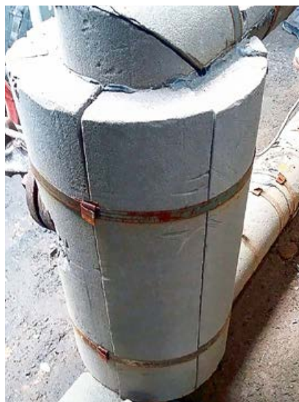
❖ Фото 1. Теплоизоляционная конструкция из пеностекла до отбора образцов для испытаний
