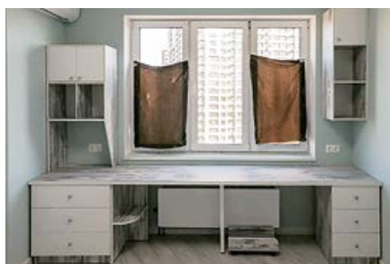
❖ Фото 4. Установка отопительного прибора под широким столом
