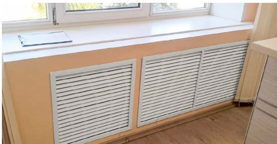
❖ Фото 3. Установка отопительного прибора в шкафном укрытии
