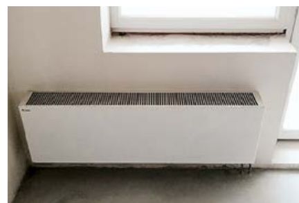
❖ Фото 5. Установка конвектора под окном в помещении кухни
