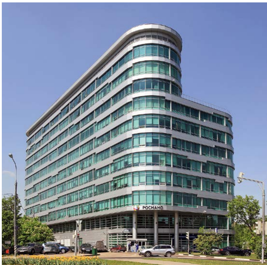
Фото 1. Здание «Роснано» как пример строения с высоким коэффициентом остеклённости
