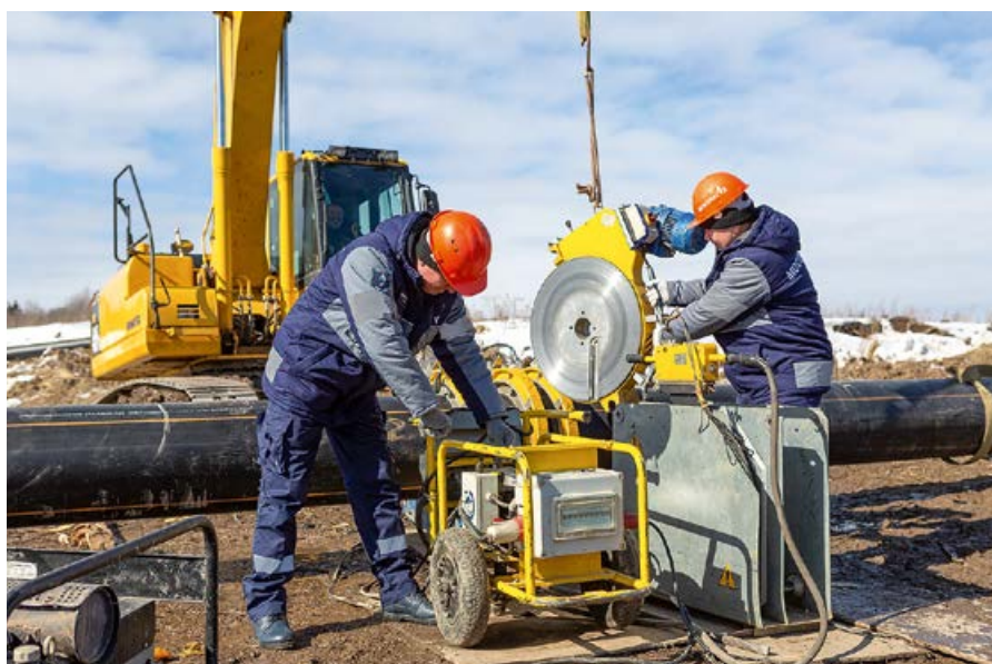
❖ Строительство газораспределительной станции (ГРС) «Жуково»
