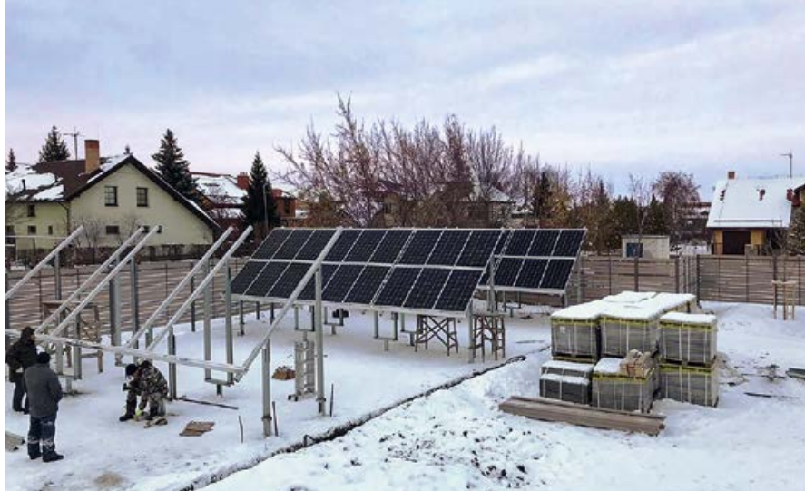
❖❖ Процесс строительства сетевой солнечной электростанции
