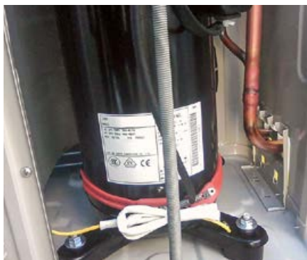
❖ Фото 3. Подогреватель картера компрессора
