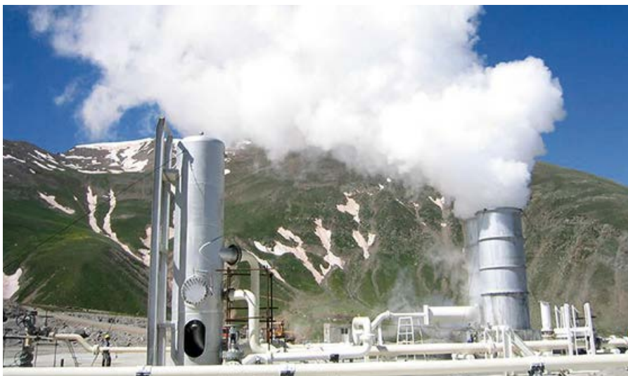
Экспериментальные скважины на геотермальном поле Мешгиншехр (Meshginshahr) в Иране
