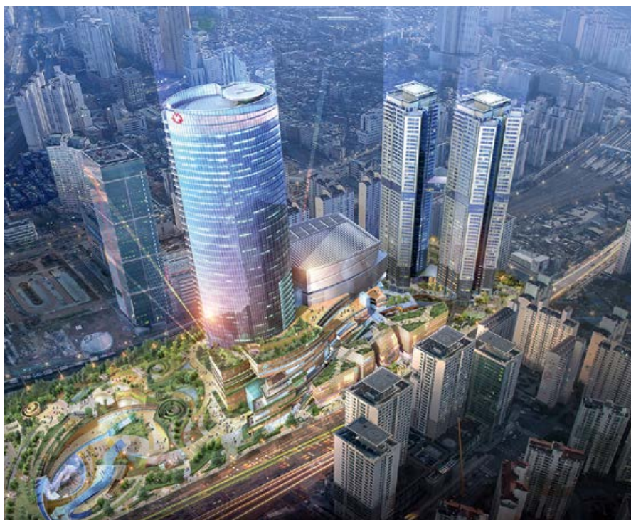
❖ Центральный офис компании Daesung Celtic Energys в городе Сеуле, Южная Корея
