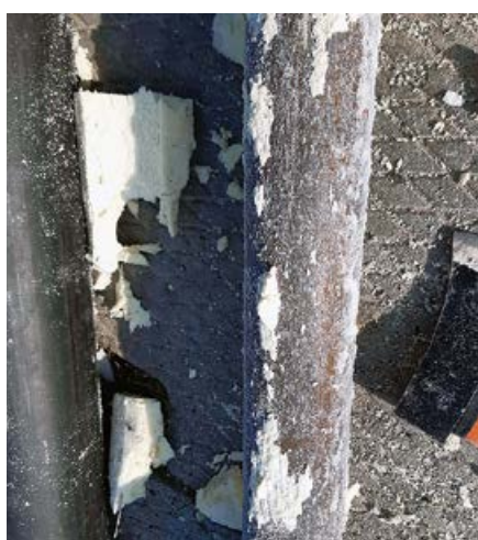
❖ Фото 6. Внутренняя поверхность трубы (гр. III)
