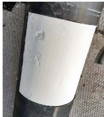
•• Фото 16. Вскрытие оболочки трубы (гр. II)
