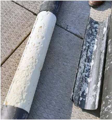
❖ Фото 17. Вскрытие оболочки трубы (гр. III)
