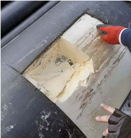
•• Фото 23. Извлечение ТИМ из трубы (гр. I)
