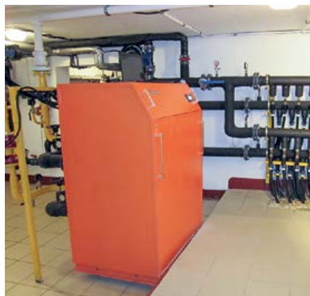
Энергоэффективный дом в посёлке Решетниково Клинского района (ул. Парковая, д. 3) оборудован ГСТ с 65 скважинами и четырьмя тепловыми насосами «Корса-55» (165 кВт)
