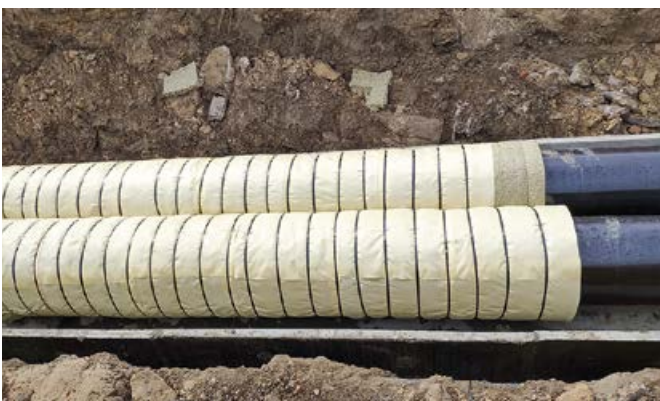
Фото 1. Участок подземной канальной прокладки после крепления тепловой изоляции стрепп-лентой ПЭТ
