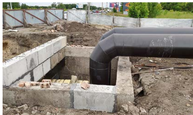
Фото 2. Вид тепловой камеры в месте смены типа прокладки, устроенной со стенами из бетонных фундаментных блоков ФБС
