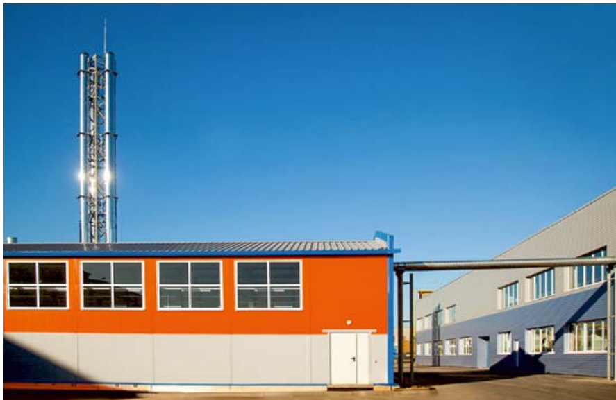
•• Котельная в городе Киржаче (Владимирская область) на основе стальных котлов серии CABK
