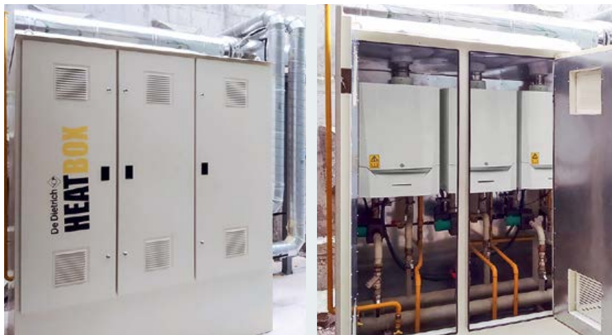
❖ Теплогенераторные установки HeatBox шкафного типа на основе котлов серии AMC Pro
