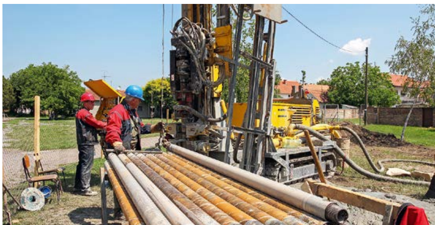
•• Подготовка к бурению геотермальной скважины
