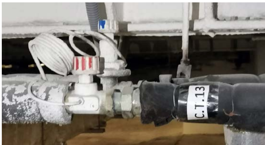
❖ Фото 3. Запорно-регулирующие клапаны, покрытые краской
