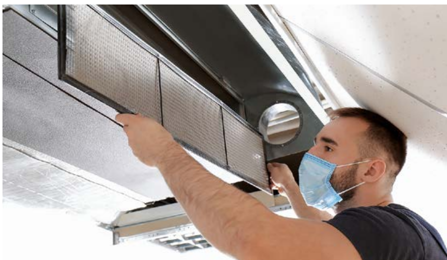
❖ Обслуживание центрального кондиционера в здании
