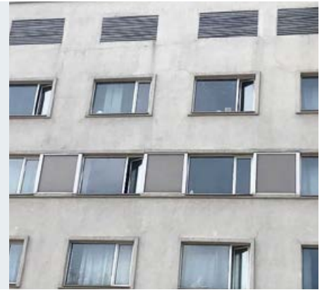
•• Фото 5. Открытые окна в дневное время (при температуре наружного воздуха t_n = +4^\circ\text{C} )
