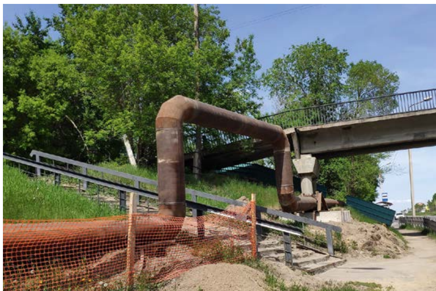
❖ Фото 2. Устройство временного трубопровода ГВС без нарушения благоустройства и демонтажа строительных конструкций объектов смежной инфраструктуры
