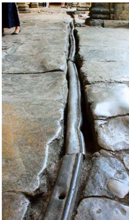
•• Древнеримский свинцовый водопровод, проложенный в Англии в I–II веках н. э.
