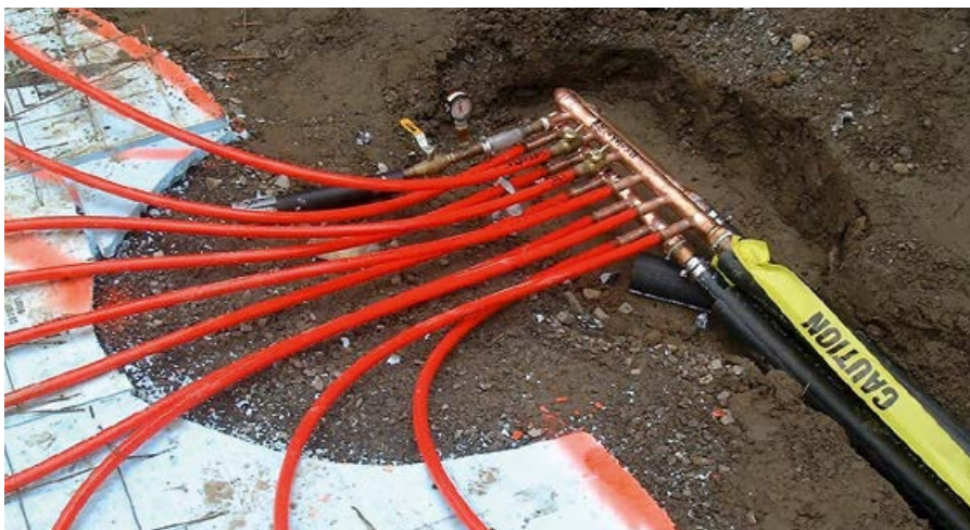
•• Система снеготаяния может снабжаться «бесплатной» горячей геотермальной водой
