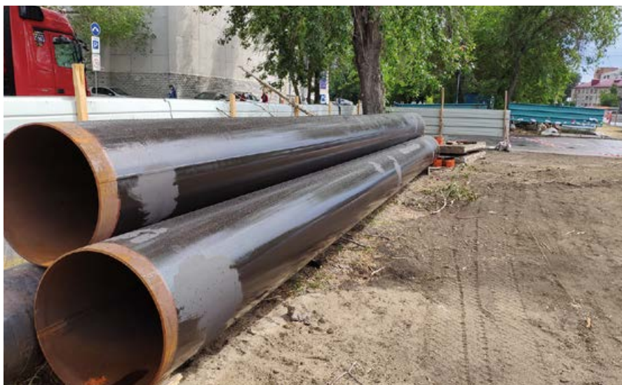
❖ Фото 1. Новые трубопроводы после нанесения антикоррозионного покрытия
