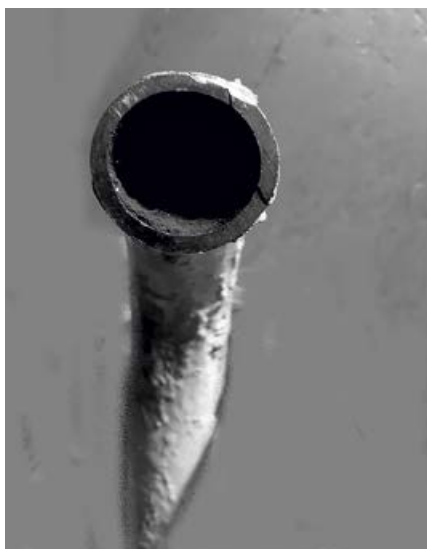
❖ Фото 3. Разрез полотенцесушителя
