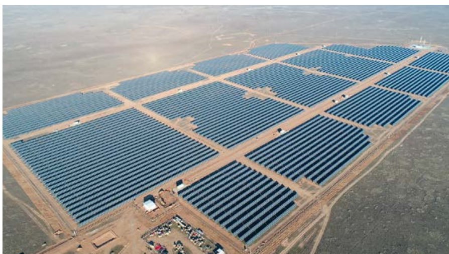
❖ Первая очередь Малодербетовской СЭС (мощность 15 МВт)
