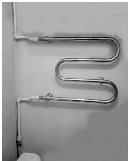
❖ Фото 1. Установленный полотенцесушитель
