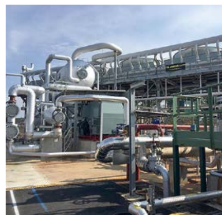
••• На материковой части Франции, в коммуне Сульс-су-Форэ (Soultz-sous-Forêts), департамент Нижний Рейн, находится в эксплуатации геотермальная электрическая установка мощностью около 1,5 МВт, построенная в середине 1980-х годов как экспериментальная. Сейчас она вырабатывает порядка 7800 МВт·ч в год
