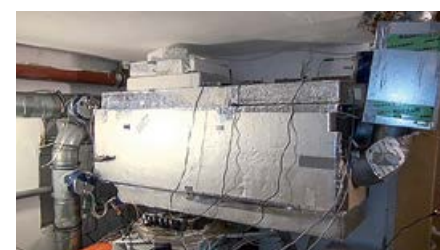
Фото 11. Вентиляционная установка первого пассивного дома после 25 лет эксплуатации
