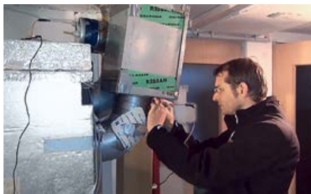
•• Фото 13. Вольфганг Хаспер устанавливает датчики на вентиляционную установку и снимает полученные данные
