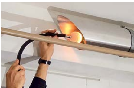
❖ Фото 21. Использование видеокamеры для контроля воздуховодов
