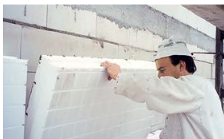
❖ Фото 4. Монтаж теплоизоляции стен первого пассивного дома в два слоя 30 лет назад
