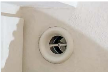
❖ Фото 18. Выкручивание вентиля в приточном диффузоре системы вентиляции в гостиной на первом этаже первого пассивного дома
