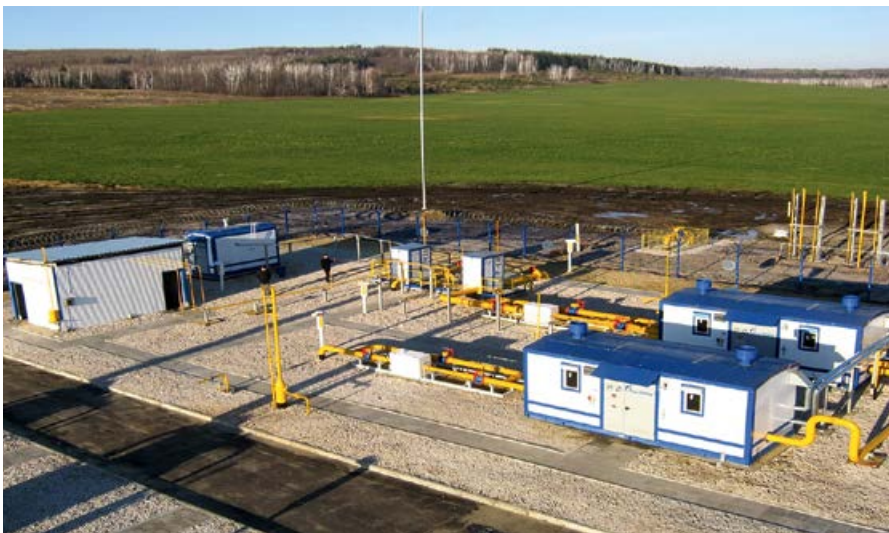
•• Автоматизированная газораспределительная блочная станция АГРС «Саратов-М(70)»
