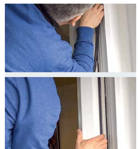
Фото 17. Замена уплотнителей на окнах
