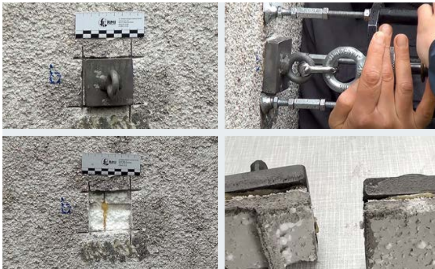
•• Фото 7. Проверка прочности сцепления штукатурки и теплоизоляции
