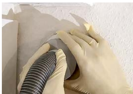
❖ Фото 19. Установка насадки-фильтра на приточный диффузор системы вентиляции
