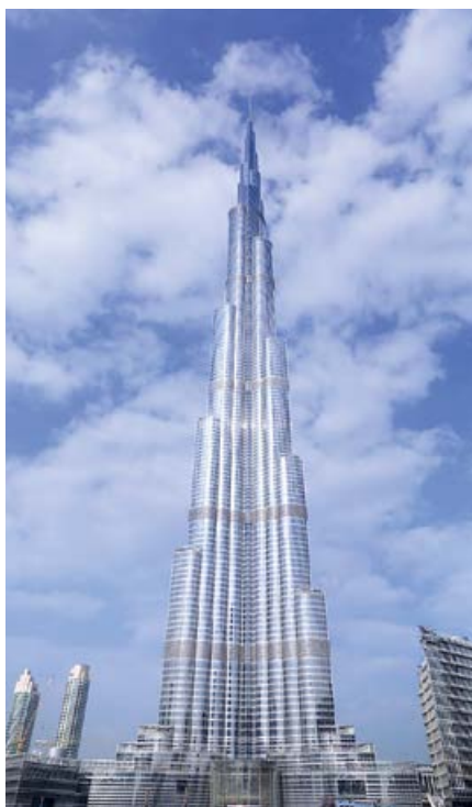
❖ Супернебоскрёб «Бурдж-Халифа» в Дубае (ОАЭ) — самое высокое (829,8 м) здание в мире
