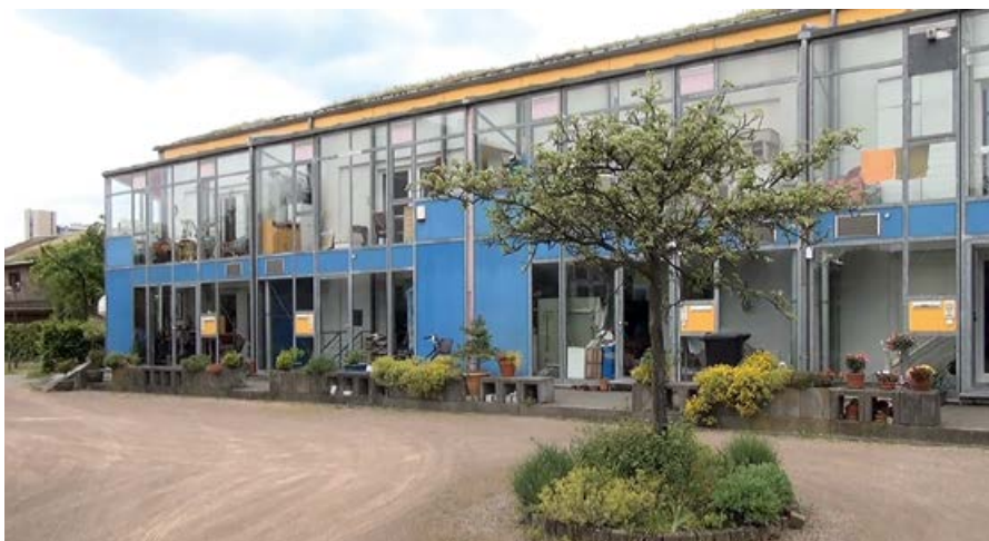
•• Фото 28. Северный фасад первого пассивного дома в городе Дармштадте
