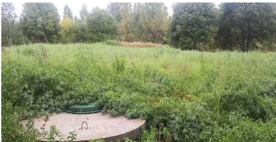
❖ Фото 5. Вид на площадку с геотермальным контуром после сезона работы
