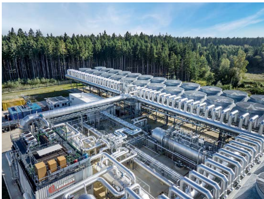
•• Баварская ГеоЭС «Хольцкирхен» (Holzkirchen) мощностью 3,6 МВт использует цикл ORC
