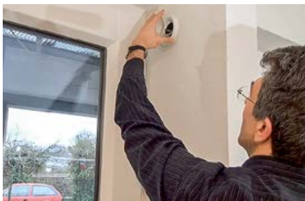
❖ Фото 18. Выкручивание вентиля в приточном диффузоре системы вентиляции в гостиной на первом этаже первого пассивного дома
