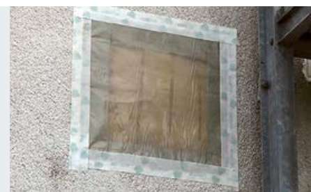
❖ Фото 6. Взятие образца теплоизоляции и временное заполнение ниши минеральной ватой
