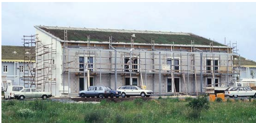
•• Фото 8. Монтаж инновационных на тот момент окон в первом пассивном доме 30 лет назад
