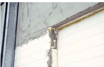
❖ Фото 4. Монтаж теплоизоляции стен первого пассивного дома в два слоя 30 лет назад
