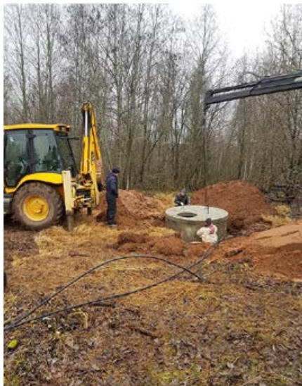
•• Фото 3. Монтаж геотермального контура
