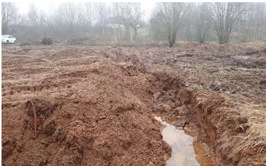
•• Фото 4. Подготовка траншей для укладки горизонтального геотермального контура
