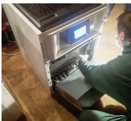
❖ Фото 7. Пусконаладка теплового насоса
