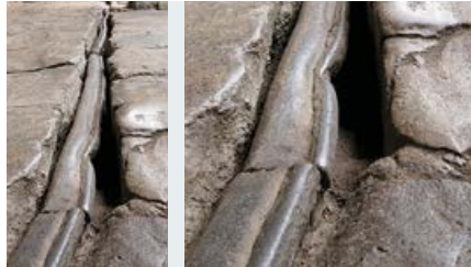
Свинцовые трубы в Европе, применявшиеся со времён Римской империи, начали запрещать относительно недавно — с 1969 года
