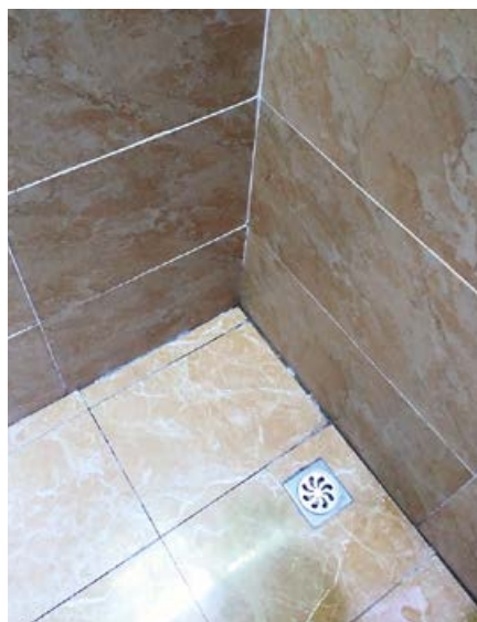
⌘ Фото 2. Типичный пол в душевой комнате в отеле в Шанхае, где на слив не установлен сифон
