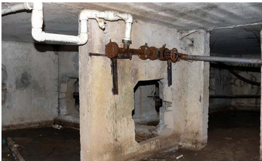
:: Типичное состояние подвала дома 1990-х годов постройки
