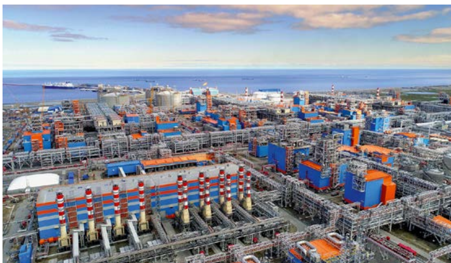
Рис. 1. Электростанция завода СПГ в посёлке Сабетта
