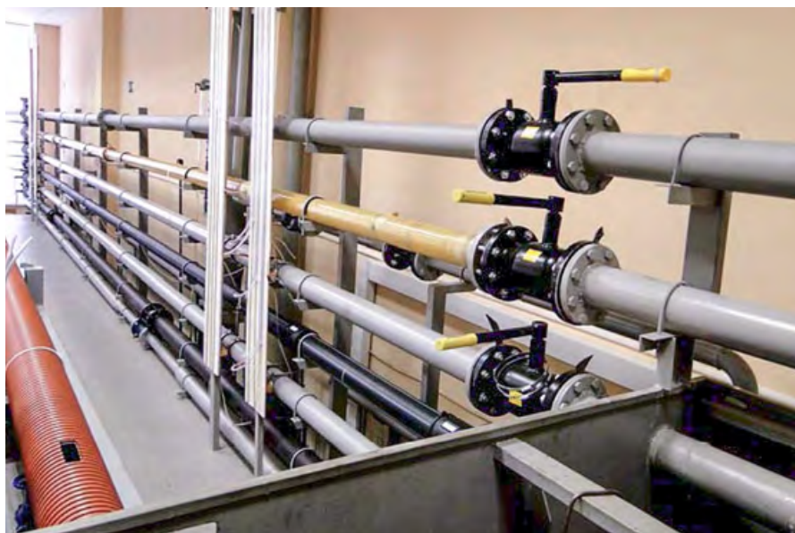
⦿ Фото 1. Общий вид гидравлического стенда с исследуемыми трубами
