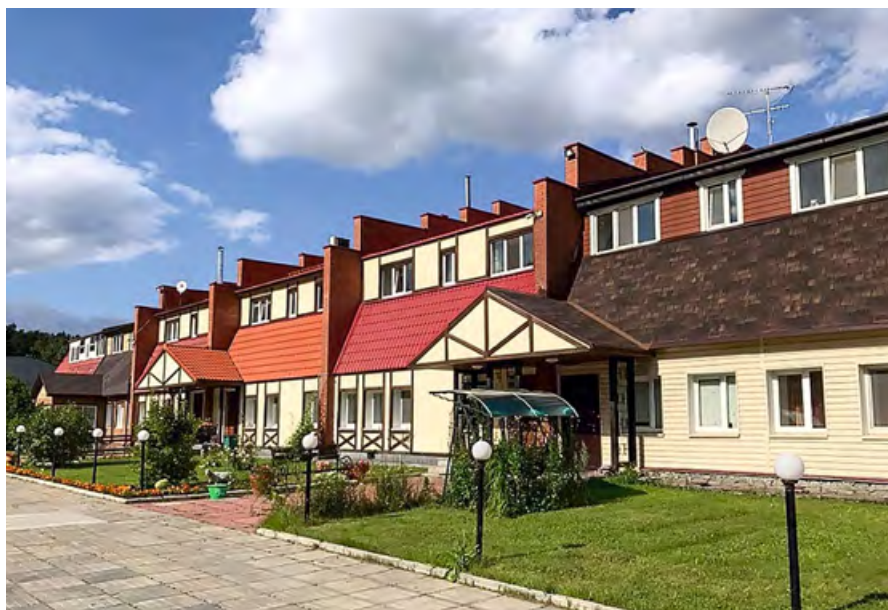
❖❖ Рис. 1. Здание коровника в посёлке Растущий было преобразовано в современный жилой дом (таунхаус) и явилось примером применения энергоэффективных технологий
