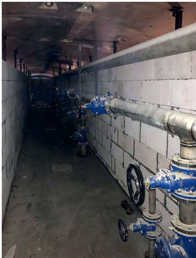
•• Узел переключения напорных выпусков
