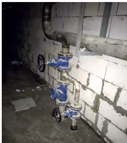
⚡ Запорная арматура на узле переключения
