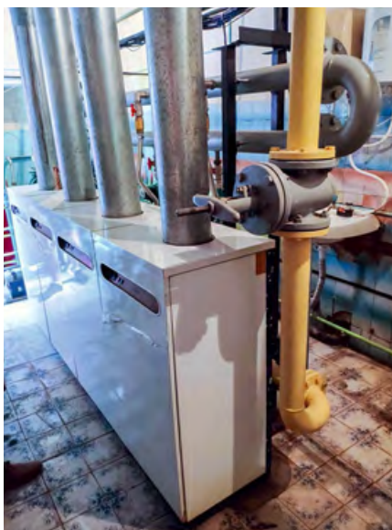
❖❖ Каскад теплогенераторов UTM-200
