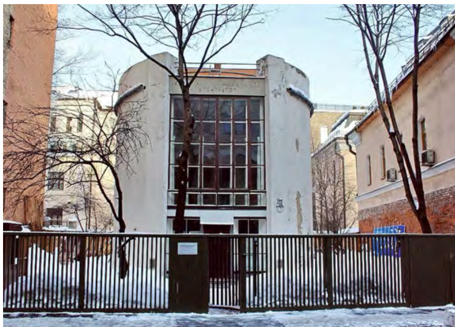
❖ Фото 1. Вид здания со стороны Кривоарбатского переулка
