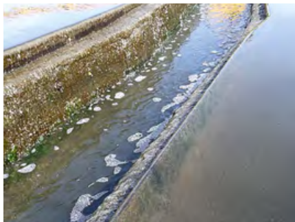
⌘ Фото 10. Всплывание в виде крупы частичек хлопков (флокул) ила на поверхность стоков вторичного отстойника
