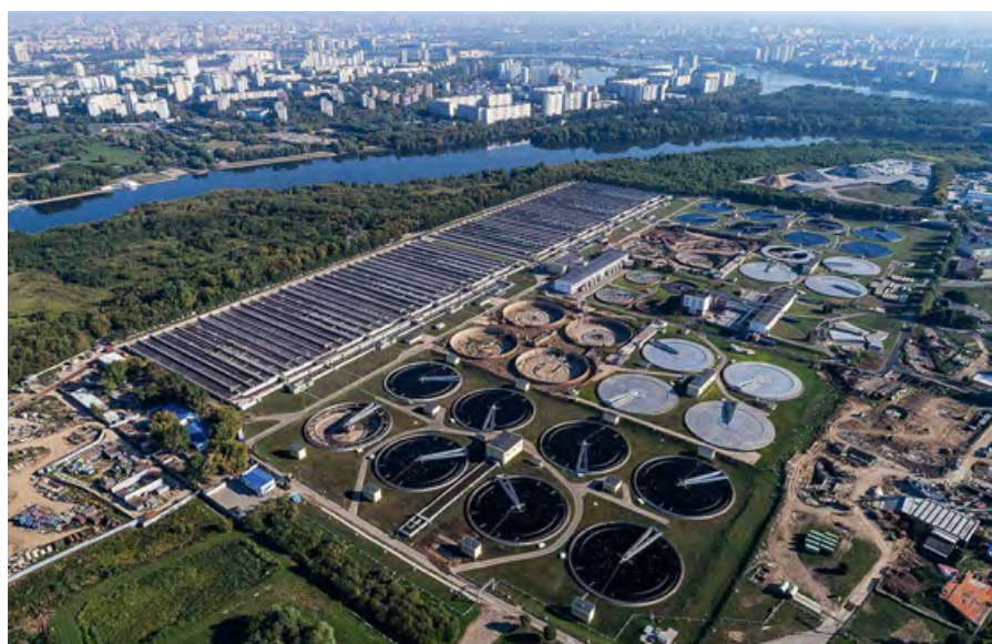
⌘ Очистные сооружения с аэрационными ёмкостями (Курьяновская очистная станция)
