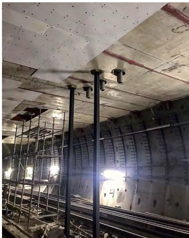
⌘ Подготовка к монтажу напорных трубопроводов
