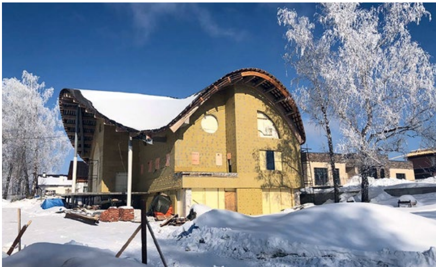
❖ Дом в Новосибирске оснащён комплексной отопительной и вентиляционной системами WOLF
