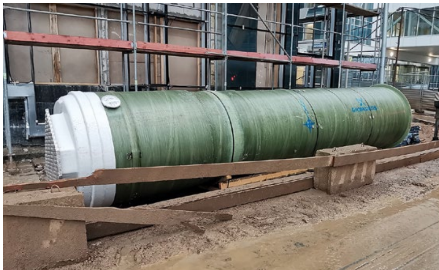
⚡ Канализационная насосная станция Grundfos в ГКБ №40 («Коммунарка»)
