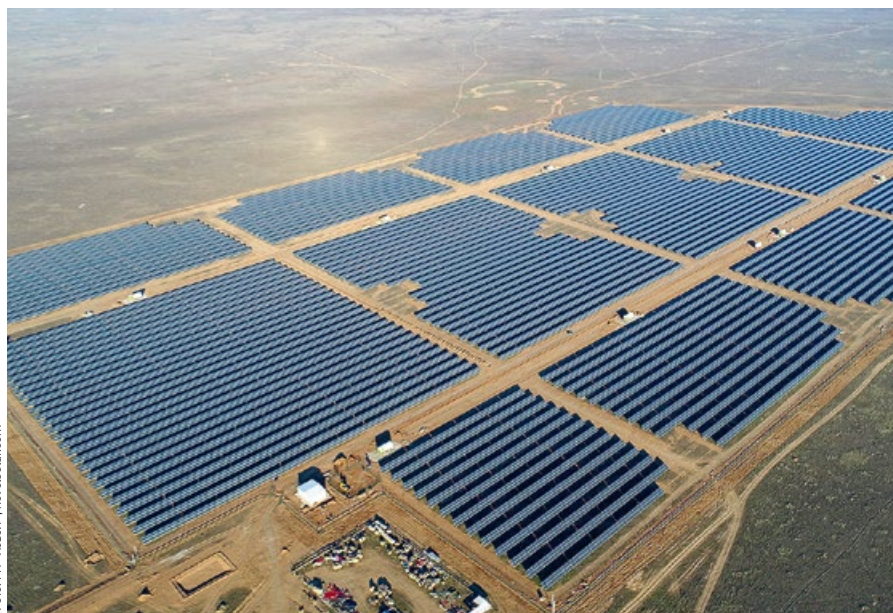
❖ Малодербетовская солнечная электростанция (15 МВт) в Республике Калмыкия
