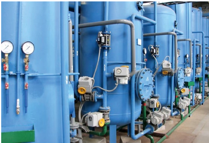
⌘ Промышленные установки умягчения воды
