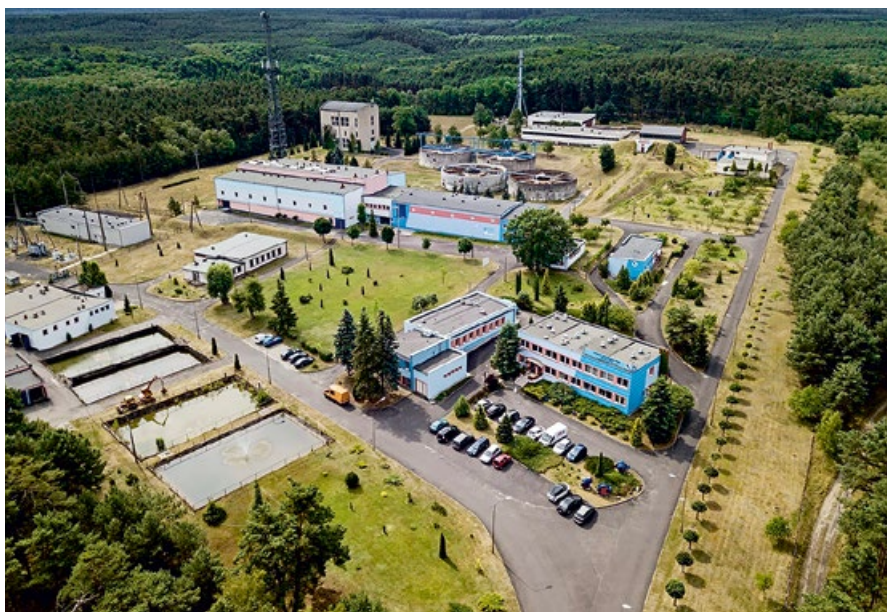
•• Рис. 3. Водопроводные очистные сооружения Zawada (Польша)
