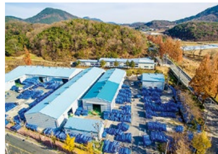
❖ Завод Kyung Hyung Industrial в Южной Корее
