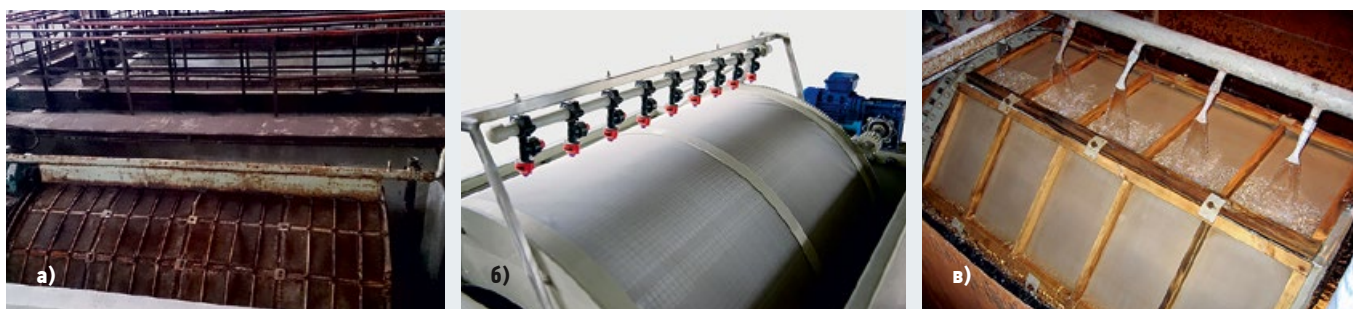
Рис. 2. Общий вид микрофильтра со стальной (а, б) и нетканой сеткой (в)
