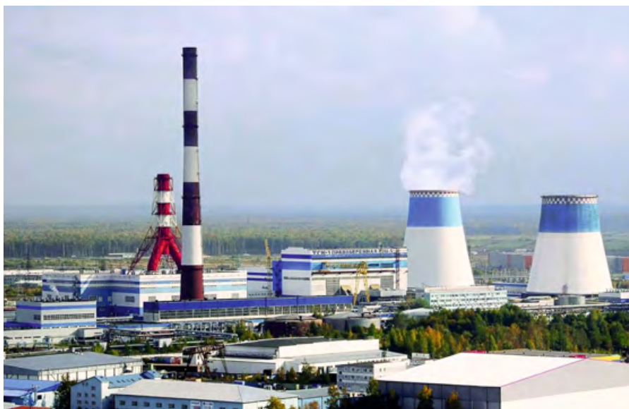
❖ Современная «Правобережная ТЭЦ» (владелец — ОАО «ТГК-1»)
