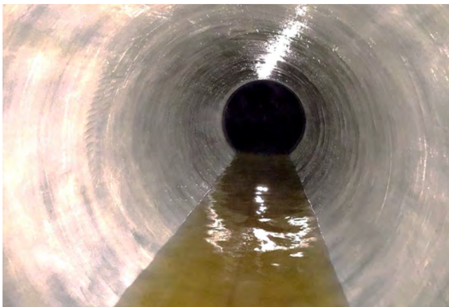
•• Рис. 3. Общий вид восстановленного комбинированной технологией трубопровода
