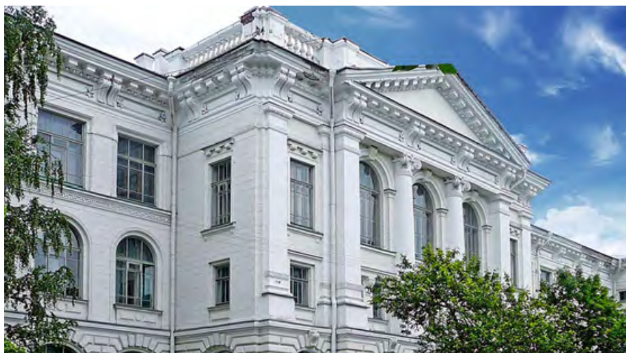
Здание Санкт-Петербургского политехнического университета Петра Великого (СПбПУ)
