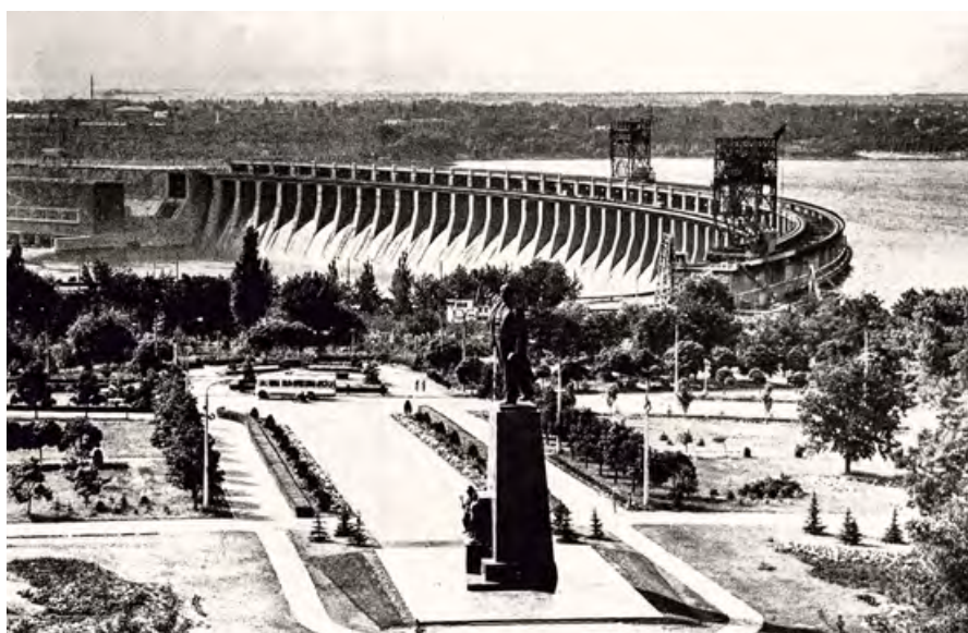
Строительство первой очереди Днепровской гидроэлектростанции (ДнепроГЭС им. В.И. Ленина), плановый пуск которой, в полном соответствии с планом ГОЭЛРО, состоялся в 1932 году
