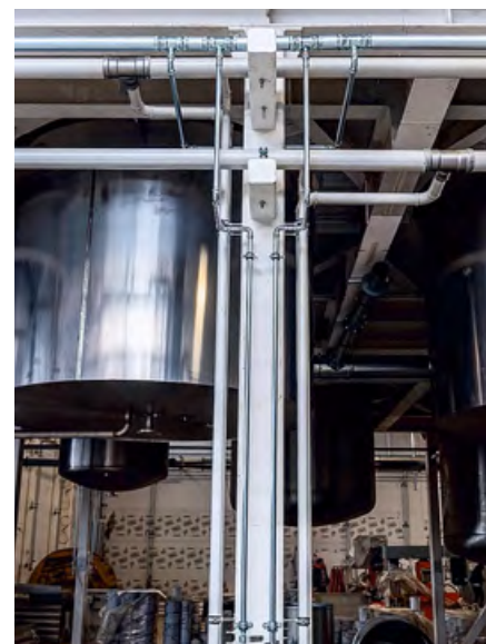
❖ Благодаря технологии Viega Megapress монтаж соединения стального трубопровода на высоте 6 м занимает всего 20 секунд
