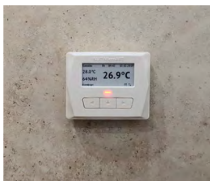
Для управления температурой бассейна используется универсальный электронный термостат
