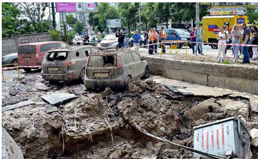
❖❖ Инфраструктура украинских городов изношена, и даже в столице Украины происходят подобные аварии (прорыв трубопровода в Киеве на Голосеевском проспекте в мае 2017 года)
