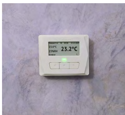
Универсальные термостаты NUT MicroART установлены в каждом помещении
