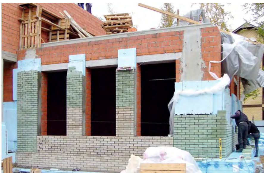
❖ Структура ограждающей конструкции энергоэффективного эко-дома
