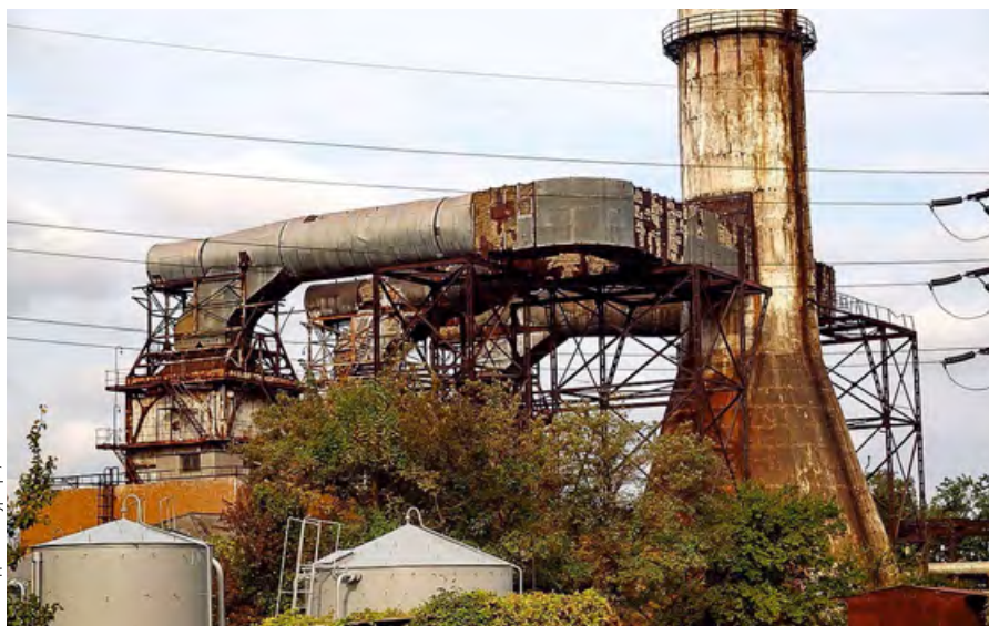
●● Котельная установка Одесской ТЭЦ, одного из важнейших инфраструктурных объектов Одессы
