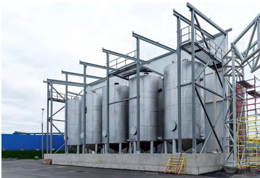
⊞ Производственный лакокрасочный цех с пристроенным административно-бытовым корпусом в подмосковном городе Лобня
