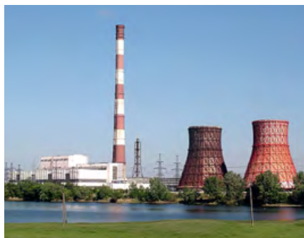
Харьковская ТЭЦ-5. Тепловая мощность — 1420 Гкал/ч, электрическая — 540 МВт
