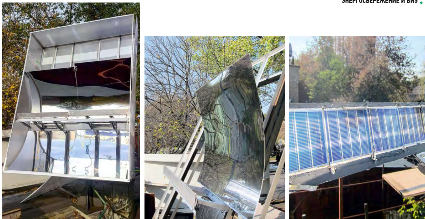
Рис. 1. Солнечная когенерационная установка на основе четырёх теплофотоэлектрических модулей
