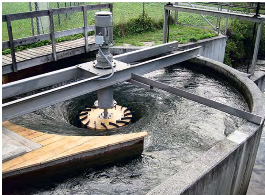
❖ Фото 1. Схема Франца Цотлётера — проект Wasserwirbeltechnik («Техника водоворота»)
