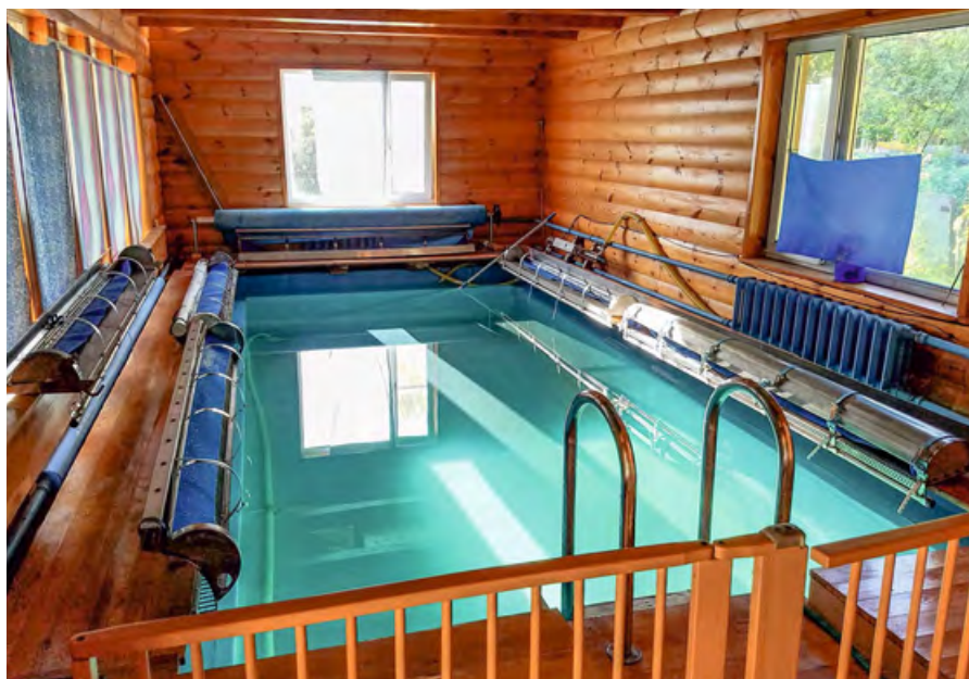
:: Рис. 3. Внешний вид опытного образца бассейна размером 3×6×1,4 м, оборудованного переливными желобами со встроенными фильтрами
