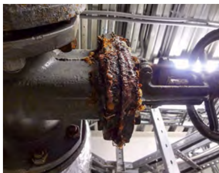
❖ Рис. 2. Коррозия элементов чугунных задвижек, установленных в индивидуальном тепловом пункте в системе горячего водоснабжения
