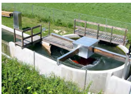
❖ Фото 1. Схема Франца Цотлётера — проект Wasserwirbeltechnik («Техника водоворота»)
