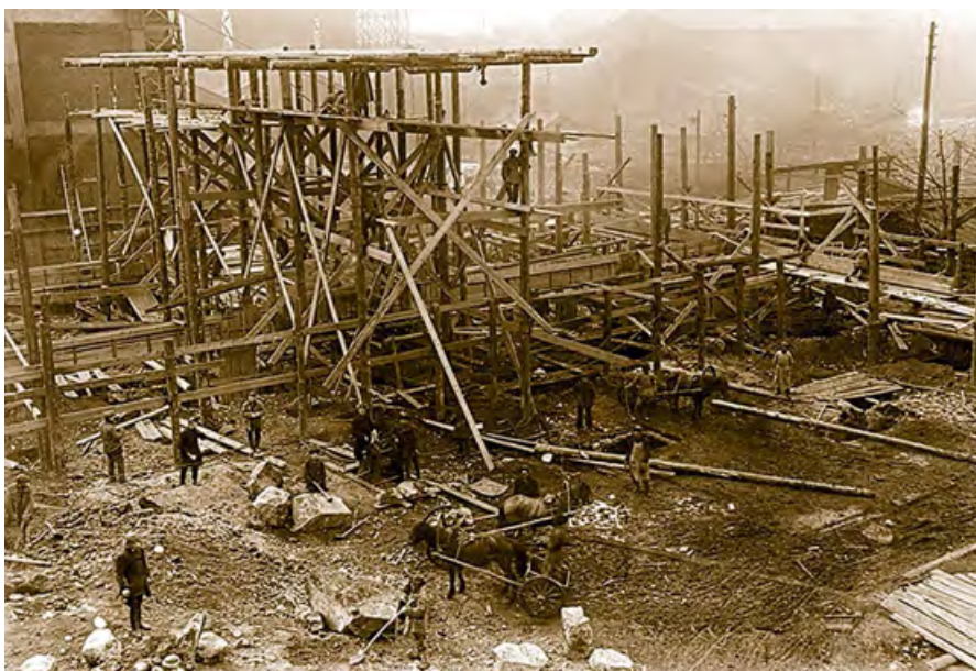
❖ Воплощение плана ГОЭРЛО — строительство Егоршинской ГРЭС в 1920-х годах
