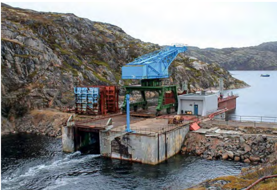
Экспериментальная Кислогубская ПЭС в 2007 году достигла мощности 1,7 МВт
