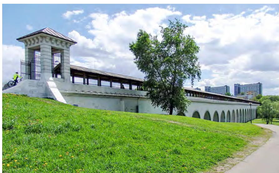
⚡ Ростокинский акведук — самый старый мост через Яузу и остаток водопровода Екатерины II
