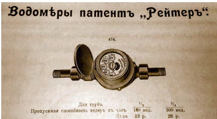
•• Актуальная техническая новинка второй половине XIX века — водомер «Рейтеръ»
