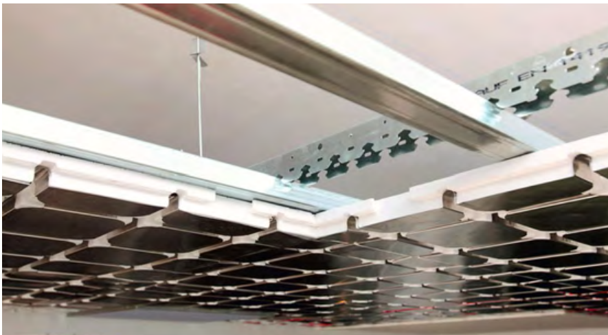
•• Внутренняя конструкция системы панельного отопления и охлаждения Giacomklima
