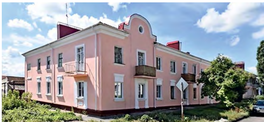
Рис. 4. Жилой дом после применения энергосберегающих мероприятий
