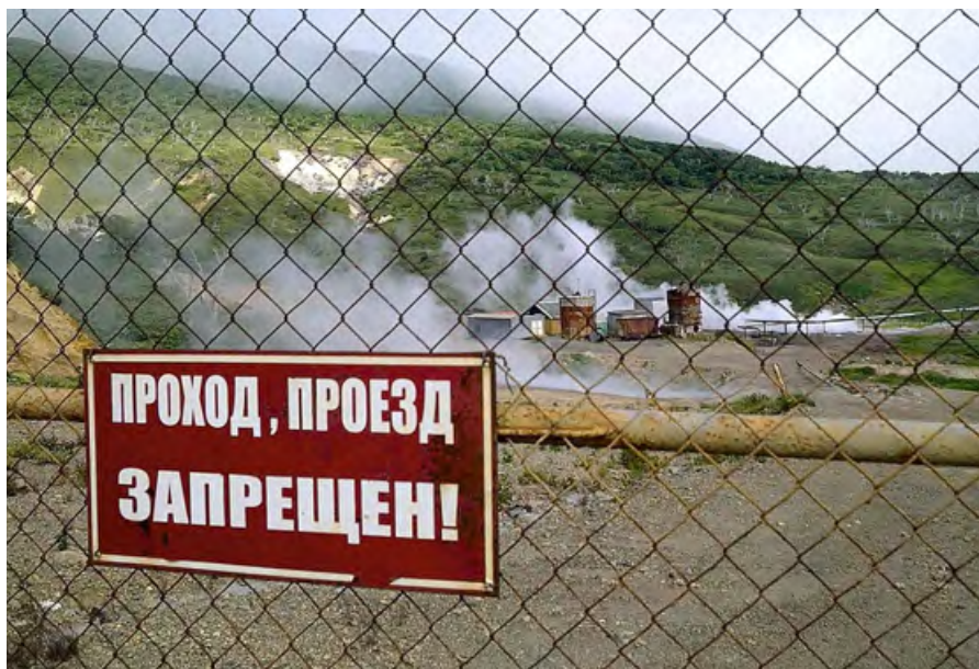
❖ Океанская ГеоТЭС на острове Итуруп была выведена из эксплуатации после аварии
