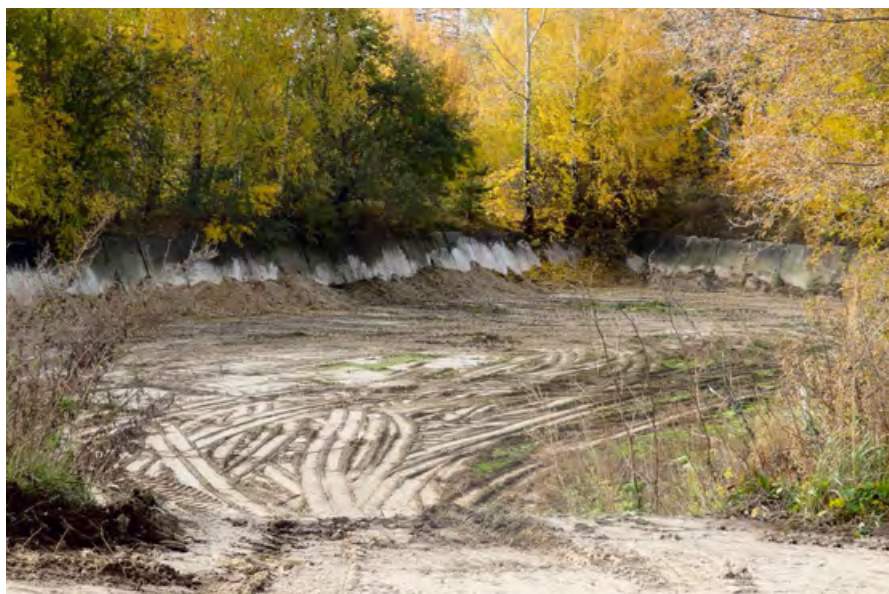
:: Фото 1. Иловая площадка после вывоза почвогрунта
