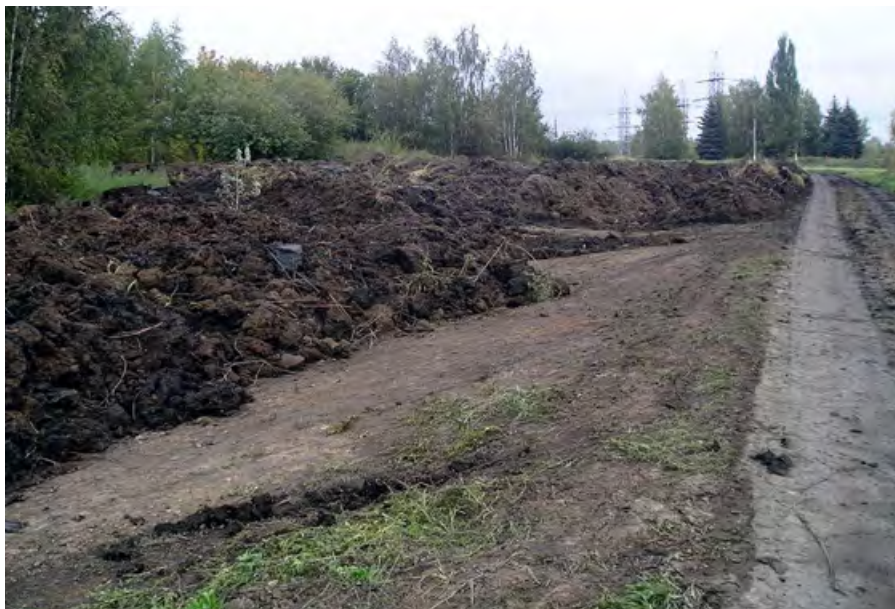
:: Фото 8. Процесс буртования осадка
