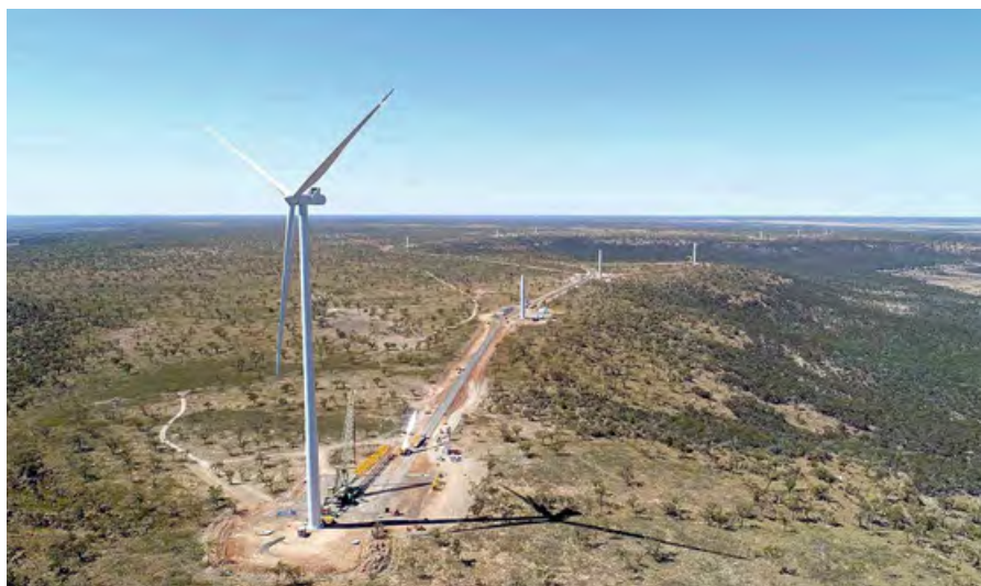
❖ Фото 1. Находящийся в Австралии проект Kennedy Energy Park компании Windlab сочетает в себе 43 МВт энергии ветра, получаемых с помощью 12 установок компании Vestas модели V136-3.6MW, 15 МВт от фотоэлектрических устройств, а также 2 МВт / 4 МВт·ч энергонакопления
