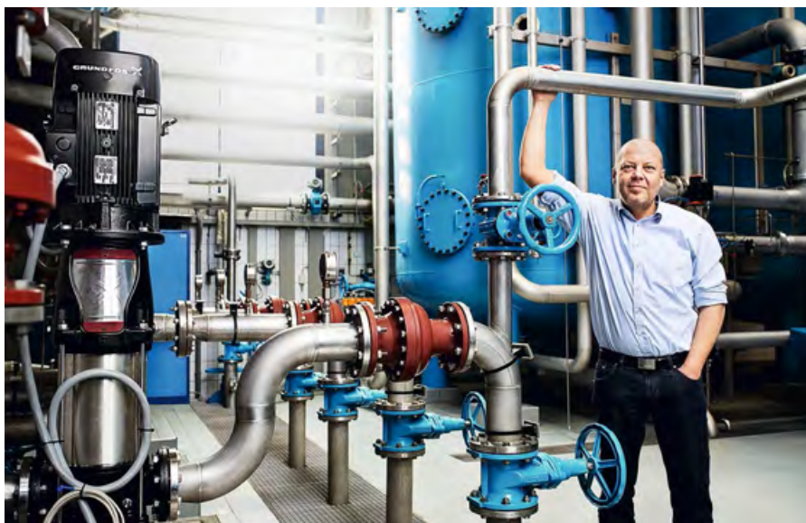
⌘ Кристиан Портши, директор водоканала в Оберварте, Южная Бургенландия, Австрия. Новый насос Grundfos CR-95 (виден слева) для повышения давления воды после песчаного фильтра на водоканале Wasserverband Südliches Burgenland
