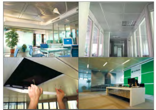
СИСТЕМЫ ПОТОЛОЧНОГО ОБОГРЕВА И ОХЛАЖДЕНИЯ
