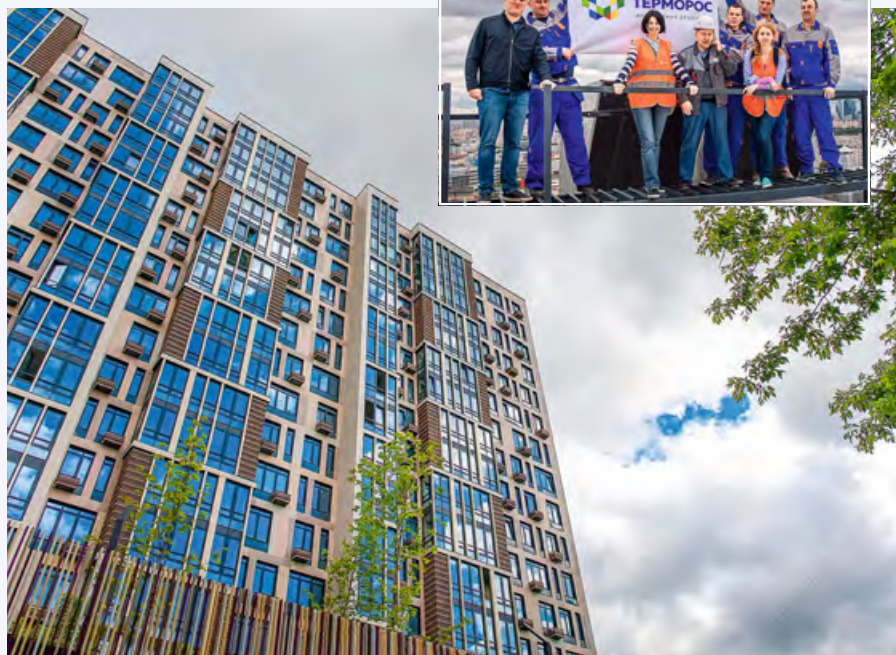
❖ Объект: ЖК «Карамель», г. Москва, 1-я Квесисская ул., д. 9. «Терморос» выполнил полный комплекс по поставке и строительно-монтажным и пусконаладочным работам внутренних инженерных систем жилого двухсекционного 17-этажного дома с подземной автостоянкой
