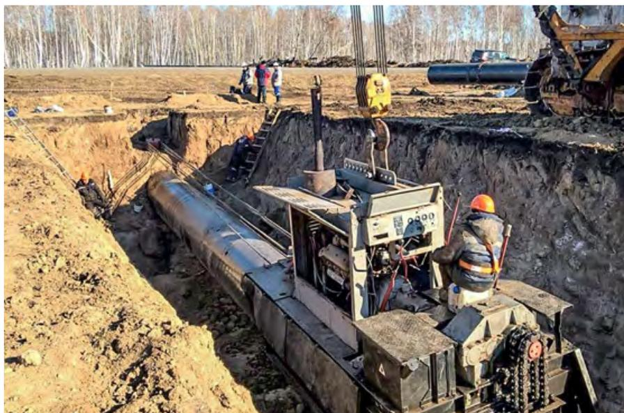
Производительность установок для проходок способом продавливания зависит от физико-механических свойств грунта, диаметра и протяжённости трубопровода, мощности домкратов, скорости и длины хода их штоков, а также от способа разработки и удаления грунта и составляет в среднем 0,5–1,5 м/ч.
