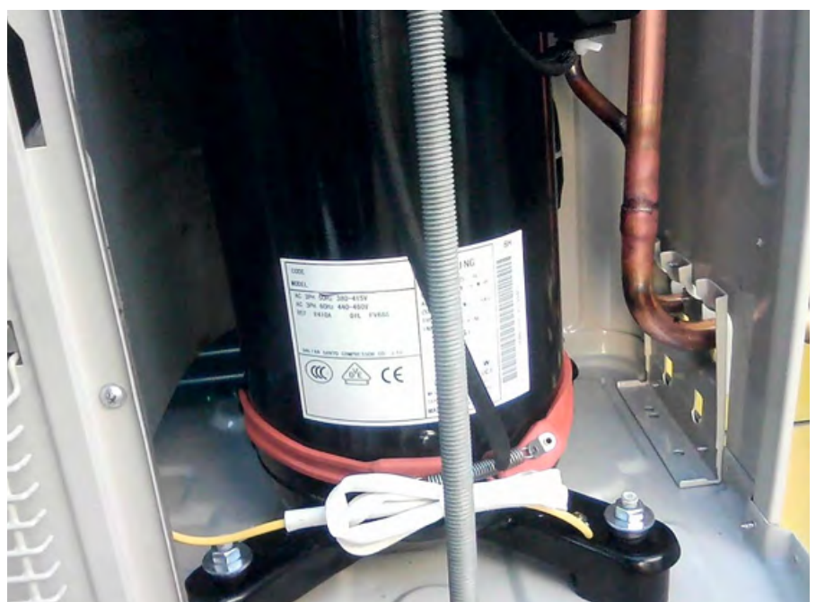
⚡ Рис. 3. Подогреватель картера компрессора
