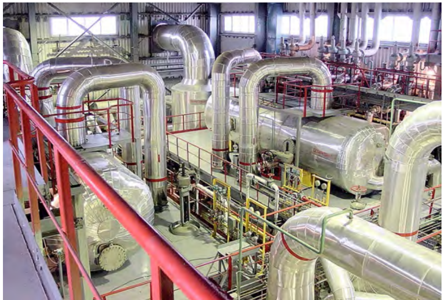
Рис. 3. Горизонтальные сепараторы в машинном зале Мутновской ГеоЭС
