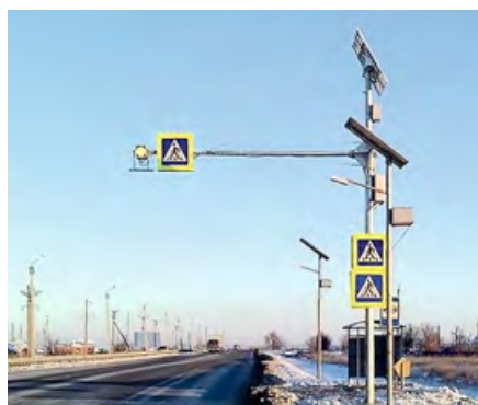
●● Рис. 8. Солнечные батареи для электропитания светофоров и освещения пешеходных переходов на трассе, соединяющей Элисту и Яшкуль (ноябрь 2016 года)
